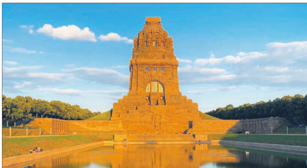
Das Denkmal 2020 nach der Sanierung des Denkmalkörpers.
